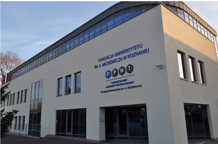
Rozbudowa zaplecza chemicznego - budynek B
