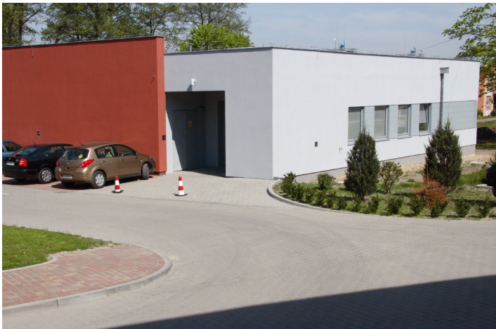
Rozbudowa Centrum Zaawansowanych Technologii Chemicznych budynek D
