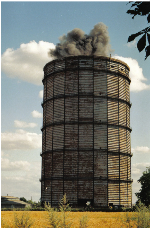
Rozbiórka zbiornika retencyjnego gazu
